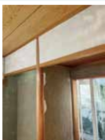
剥がし作業の経過
