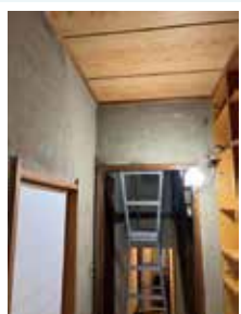
施工前の京壁
