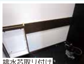
排水芯取り付け
