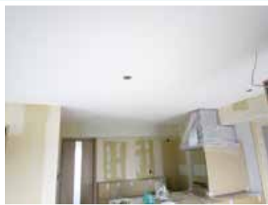
天井のクロスを貼ったところ
