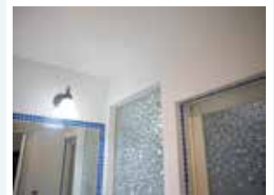
天井と壁のクロスを張る
