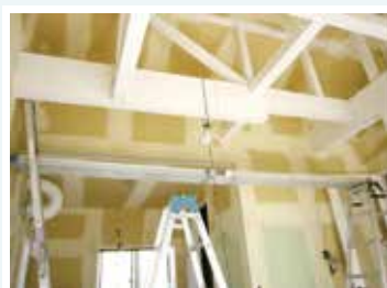
足場を作って作業
