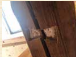
チギリ②に合わせて柱に墨入れ、 鑿で掘ってポンドをつけ、チギリを押込む
