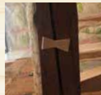
チギリ②に合わせて柱に墨入れ、 鑿で掘ってポンドをつけ、チギリを押込む
