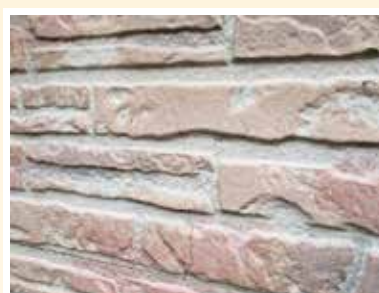
壁の多少のひび割れからの判断もできず
