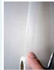
壁紙の継ぎ目になる部分に和紙テープを貼る
