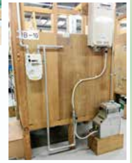
配管の切り回し方や ガス栓の増設・移設 に必要なことについて 学びました
