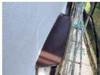
出幅に問題がなければフードだけを取り除き下地の作成
