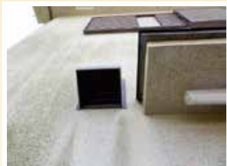
フードの中の換気扇本体の出幅を確認
