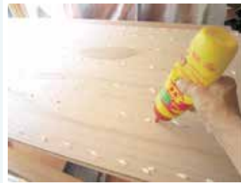
ベニヤ裏にボンドを細かく点付けする
