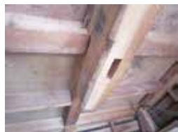
柱を抜いた痕跡のある梁
