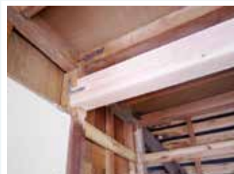
梁を組んで金具で固定して完了
