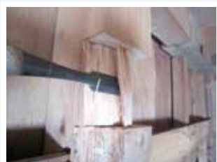
新しい梁を組むために接合部分を作る
