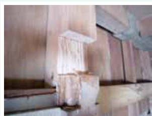
新しい梁を組むために接合部分を作る
