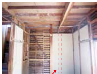
ここにあるはずの柱が抜かれている
