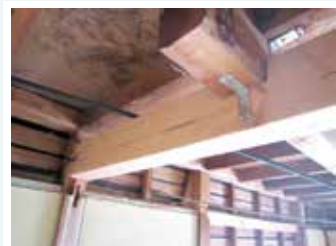
梁を組んで金具で固定して完了
