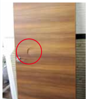
施工前（事務所）
