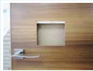
ひび割れた箇所を四角に切り抜く
