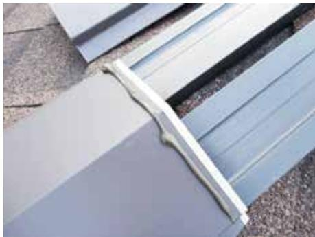
屋根のてっぺんの棟板金の中のヌキ板を木から樹脂に変えて飛ばされにくくする。
