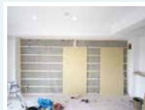
木下地を組んで石膏ボードを張る
