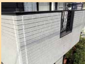
↑写真② 施工前
