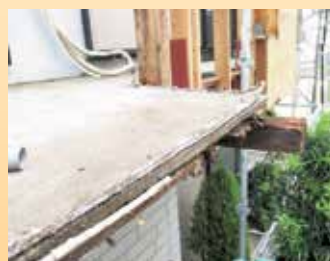
↑写真④ 解体後
