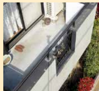
↑写真① ベランダの壁は、ほとんどが手すり付きの笠木です。
