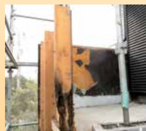
↑写真③ 解体後
