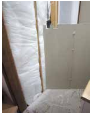
シミのある石膏ボードを剥がし、柱と断熱材の状態に
