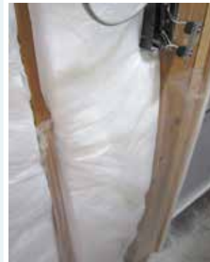
柱、間柱にビニールを張る
